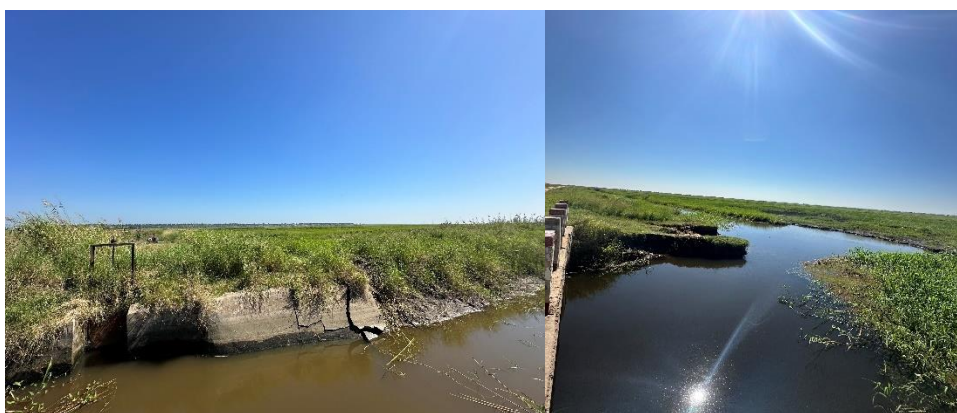
Figura 13. Vista frontal do estado de degradação de canal de drenagem na ZEEA-L
