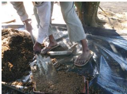
Figura 5 e 6. Acondicionamento e compactação da massa no molde
