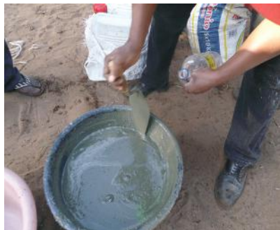
Figura 2. Mistura do cimento, sal e água
