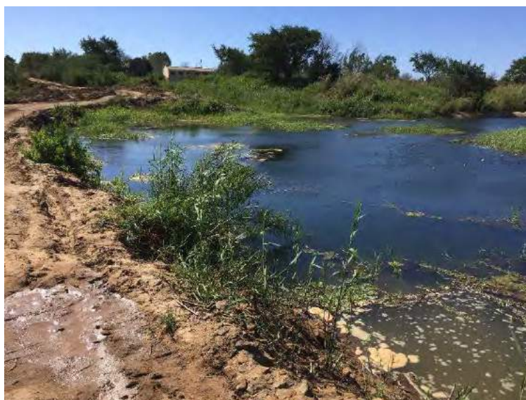
Figura 4: Reservatório Assoreado
