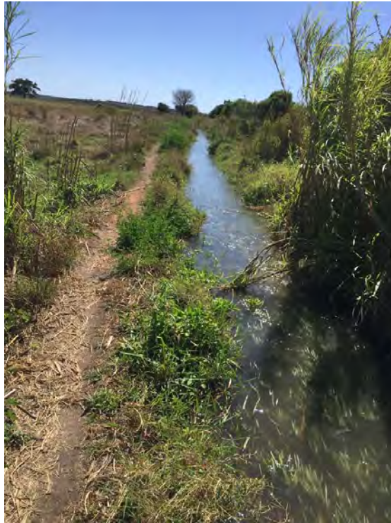
Figura 5. Estado actual de um canal de rega.
