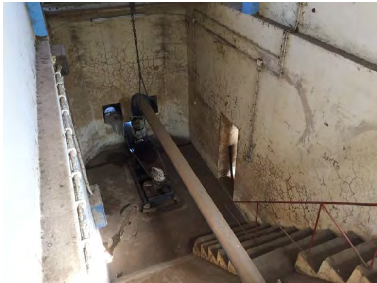
Figura 6: Única Electrobomba actualmente em funcionamento
