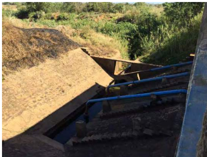
Figura 3: Vista actual do canal de acesso à tomada de água.
