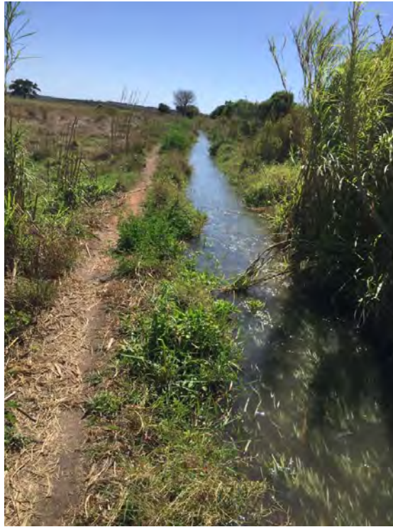
Figura 5: Um dos vários canais com evidentes sinais de degradação
