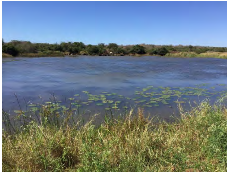
Figura 2: Reservatório assoreado; observam-se bovinos abeberando.
